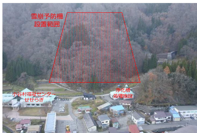
下里瀬地区の斜面
