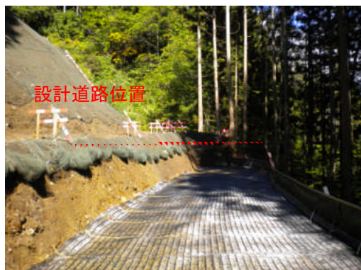
< 補強土壁工施工状況 >
