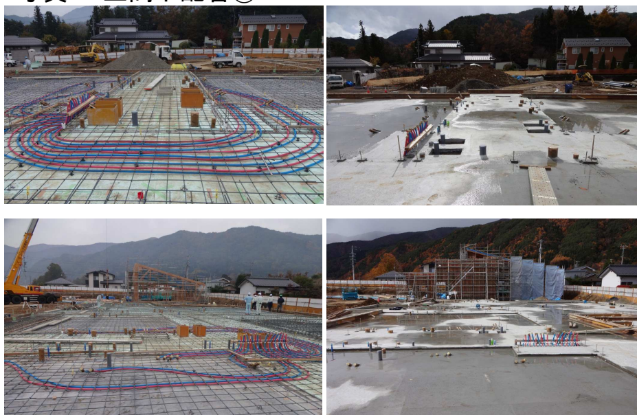
写真 土間下配管①
